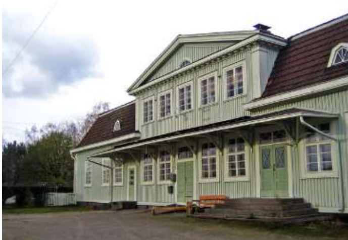
Kuva 25. Raision rautatieasemarakennus (Turun-Uudenkaupungin ja Raisio-Naantalin rataosuuksien kulttuuriperintöinventointi)
