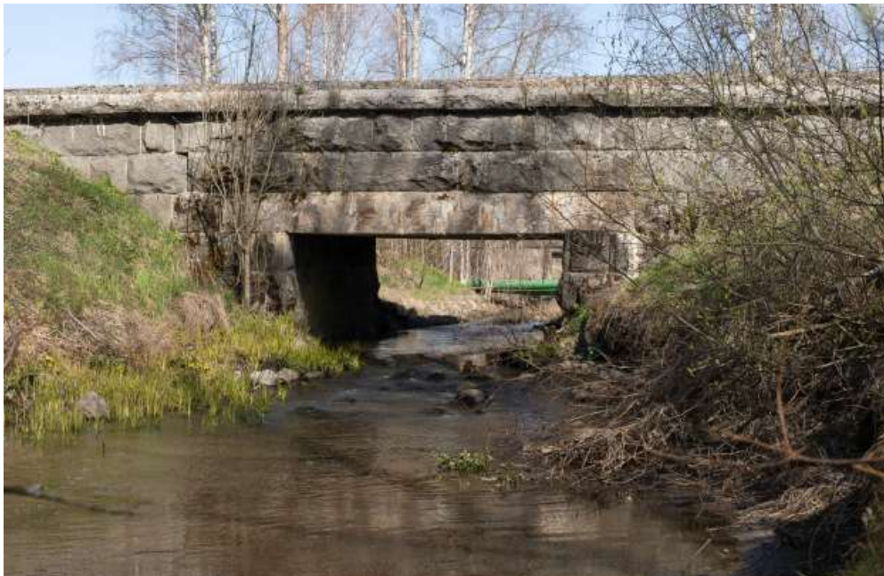
Kuva 26. Piuhanojan ratasilta (Turun-Uudenkaupungin ja Raisio-Naantalin rataosuuksien kulttuuriperintöinventointi)
