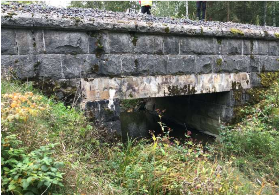
Kuva 6. Piuhanojan ratasillan eteläpuoleinen silta-aukko
